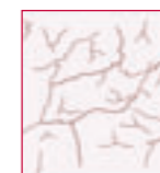
Cavillature a ragnatela dovute al ritiro dell'intonaco
