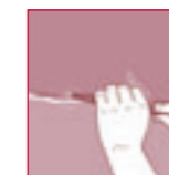
Aprire e pulire accuratamente la crepa asportando l'intonaco ammalorato
